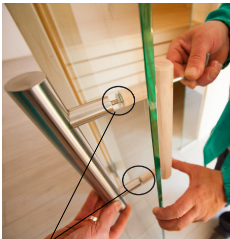
Applicare rondelle di plastica nelle maniglie Nirosta
